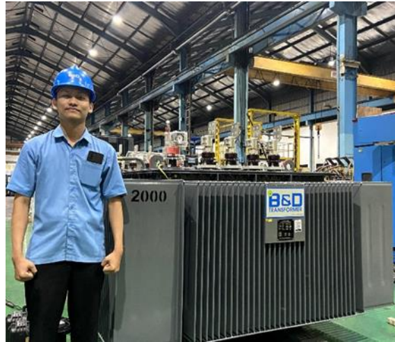
Gambar 3.3. Lulusan prodi Teknik Listrik Industri yang bekerja di PT BAMBANG DJAJA (B&D TRANSFORMER)
